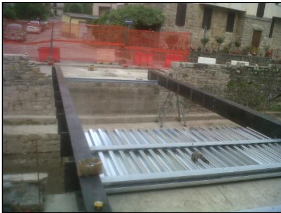
Figura 10 realizzazione ponte - Gaiole in Chianti
