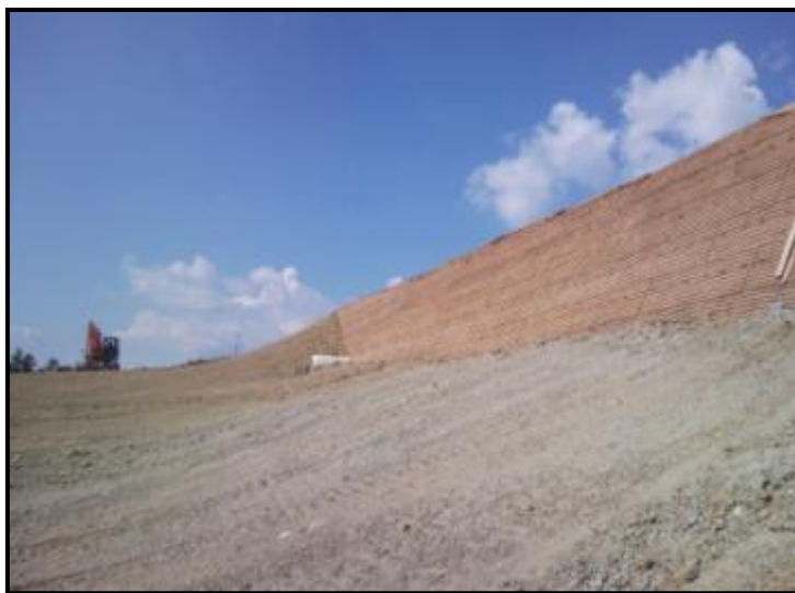
Figura 1 terre armate-A.P.S. S.P. 73 località Frosini
