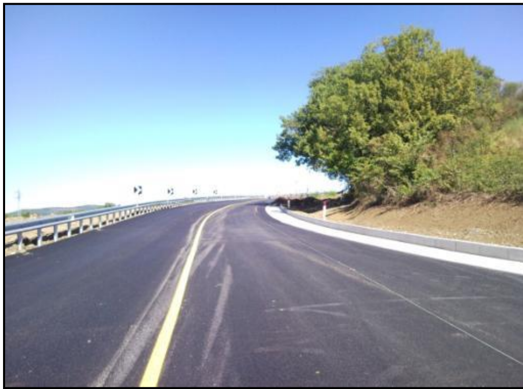
Figura 3 strada – A.P.S. S.P. 73 località Frosini
