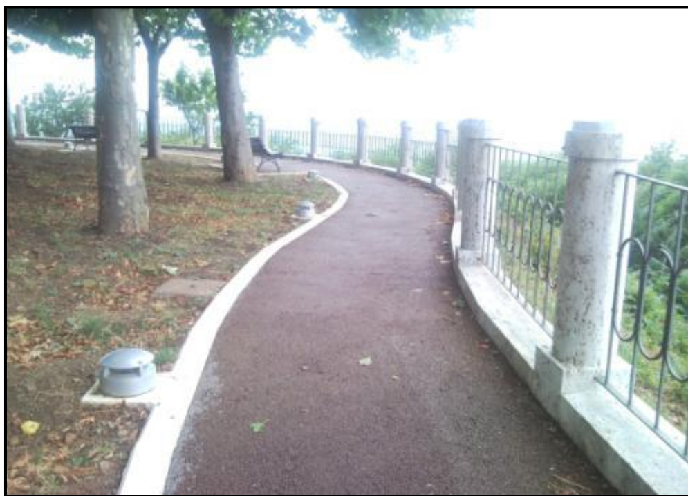
Figura 7 realizzazione di marciapiede in conglomerato ecologico – Montalcino
