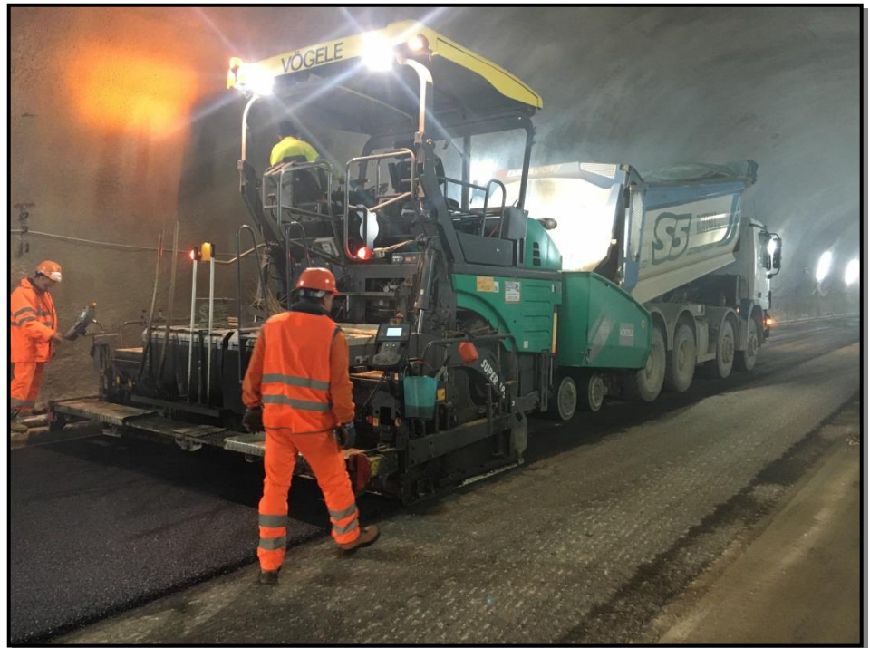
Figura 16 pavimentazione in galleria
