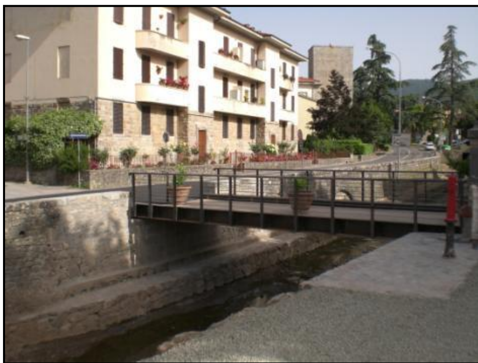
Figura 11 realizzazione ponte - Gaiole in Chianti
